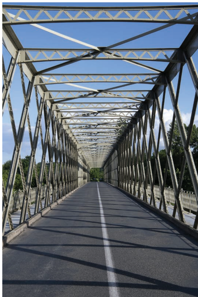
Béhuard. Pont des Lombardières.
